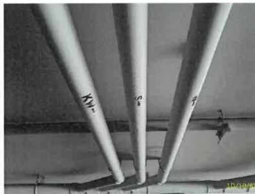
ท่อรวบรวมน้ำภายในอาคาร
